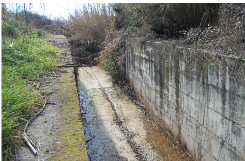
Figura 22. Vista de la llera del torrent del Mig, en els diferents trams aigües amunt la canalització soterrada.
