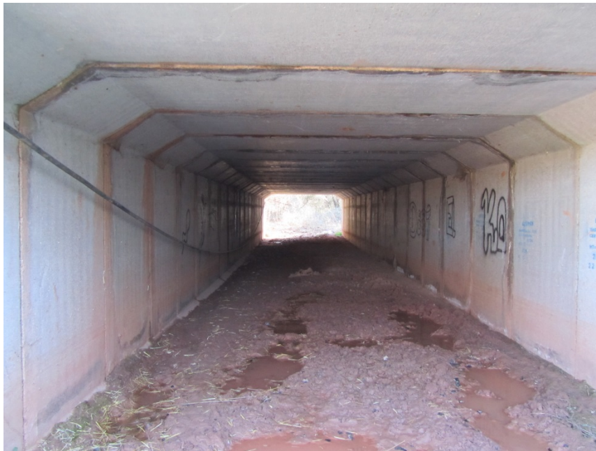
Figura 27. Estructura SH_01, torrent de Sant Hilari, secció aigües amunt.
