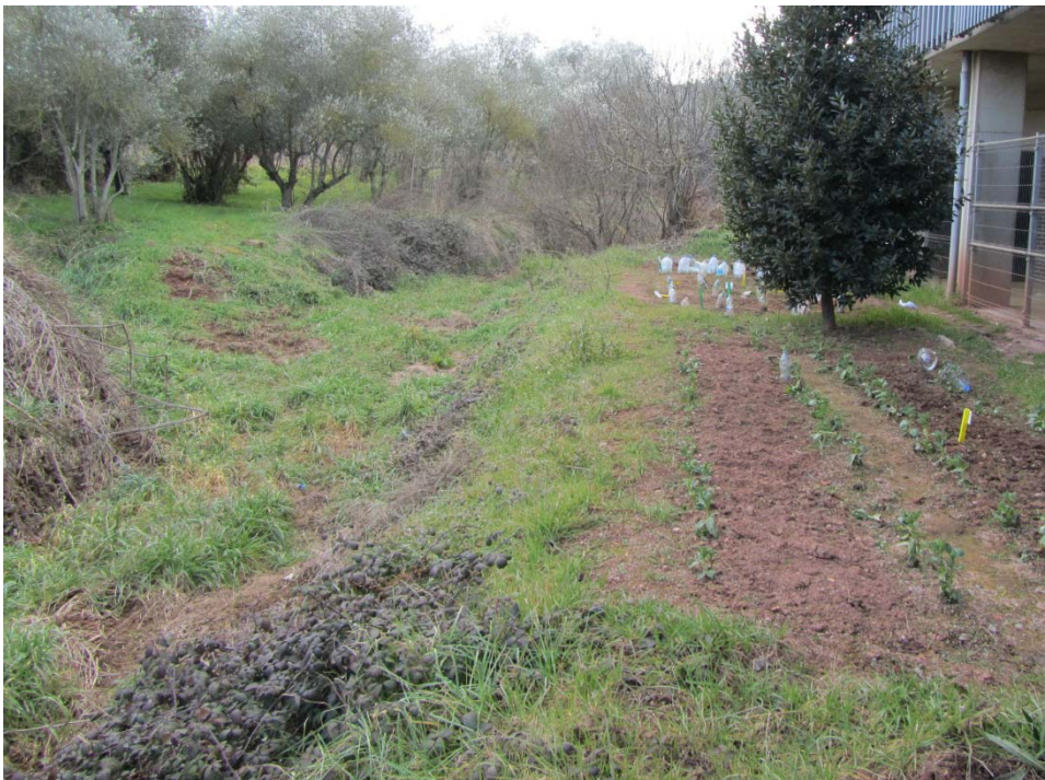
Figura 21. Vista de la llera del torrent de l'Institut, en els diferents trams aigües amunt la canalització soterrada.
