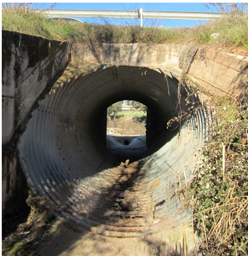
Figura 28. Estructura SH_02, torrent de Sant Hilari, secció aigües amunt.
