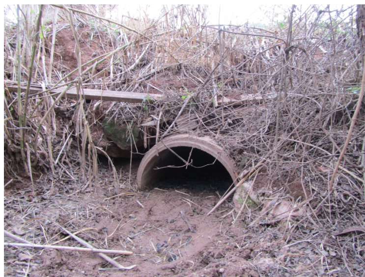
Figura 30. Estructura MI_01 i MI_02, torrent del Mig, seccions d'aigües avall.
